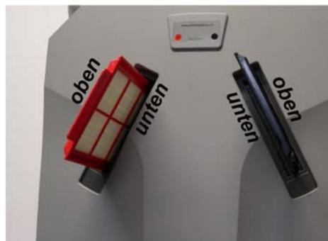
4. Die neuen sauberen Filter in das Lüftungsgerät schieben.
