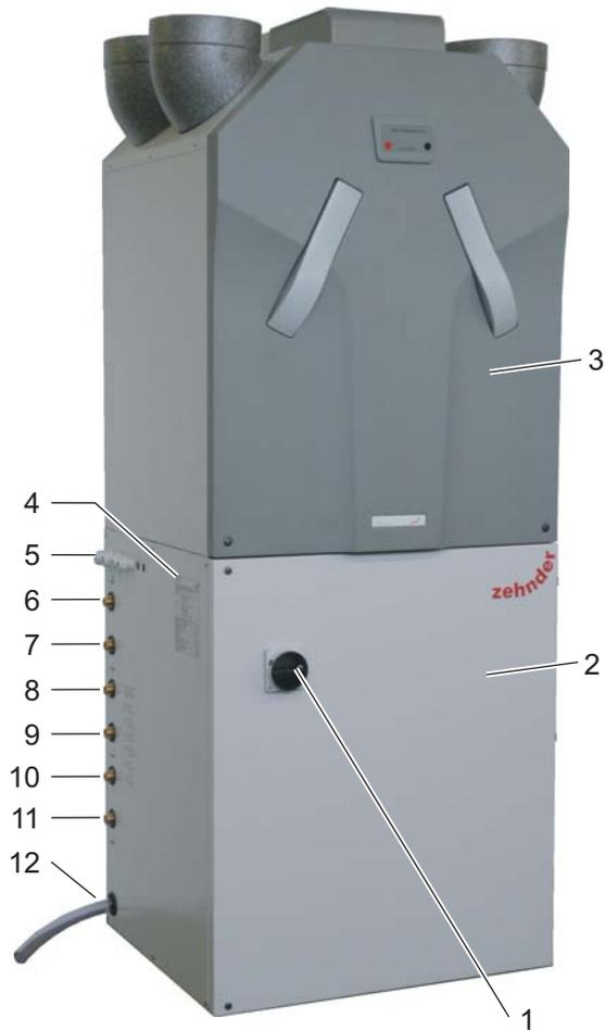
Fig. 3 Aufbau ComfoBox apart
